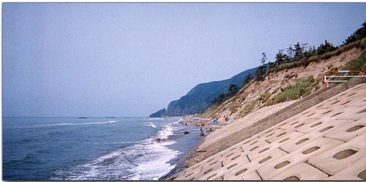
写真 4-1. 角海浜（写真の手前はブロックで保護されているが先の方は、土手はまだ壊れているようである：志波）
