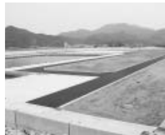
整備が進む奈古漁港
