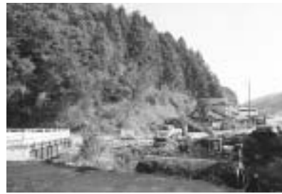
改修工事が予定される黒川橋
