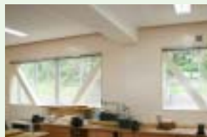
筋かいを入れ 強度を増した技術室
