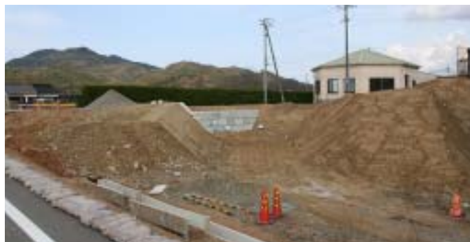
吉岡土建が建築中のバイオマス施設
