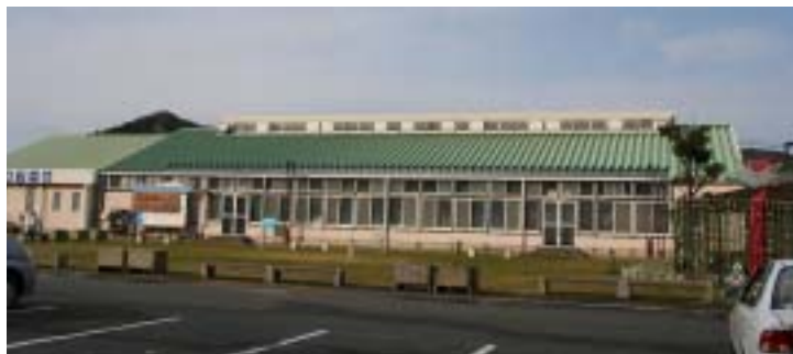
道の駅温水プール屋上に太陽光発電施設を建設
