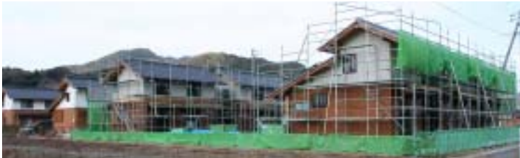
建設中の 岡田橋団地
