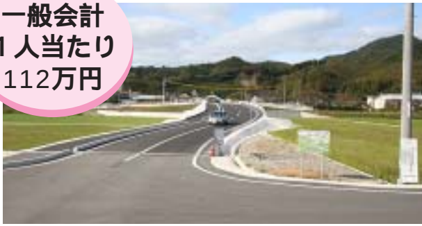
一部開通した町道汐入野地線バイパス
