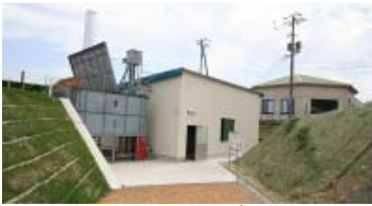
テルメ阿胡、温水プールに熱源を供給するチップボイラー施設
