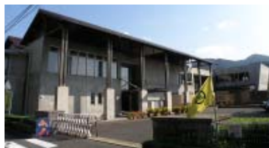
宇田郷地区で改修中の 阿武町地域交流・高齢者福祉複合施設
