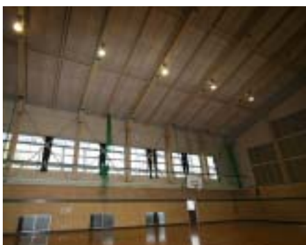
福賀小中学校屋内運動場耐震改修工事
