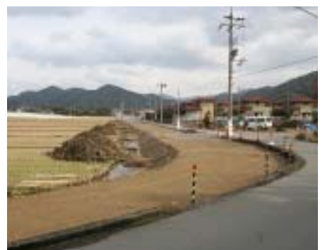
町道汐入野地線道路新設工事
