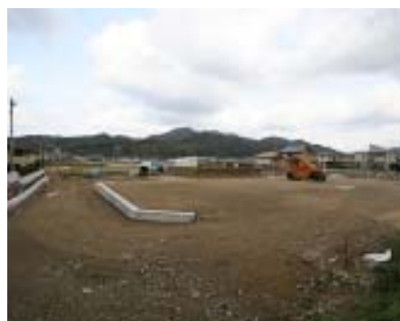
第2 美咲団地造成工事
