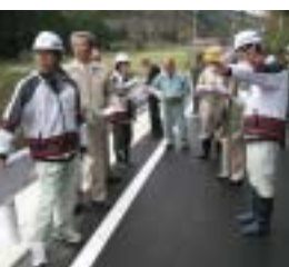
町道元浦平原線 道路改良工事
