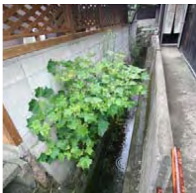
郷川移設後に造られた水路
