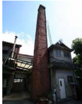
酒米を蒸すときに使用したレンガ造りの煙突
