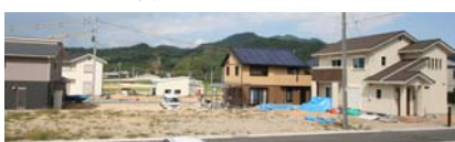
住宅建設が進む美咲第2分譲宅地
