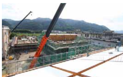
改築中の奈古小学校
