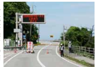
国道191号線通行止め
