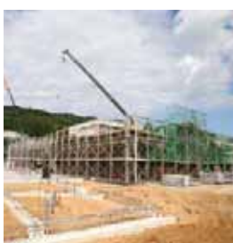
改築中の奈古小学校
