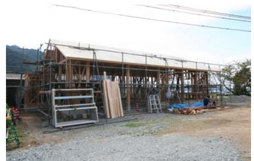
建設中の奈古浦消防器庫
