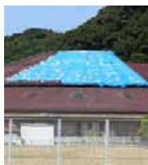
ひだまりの里 屋根防水工事
