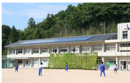
阿武中学校に設置された太陽光発電設備
