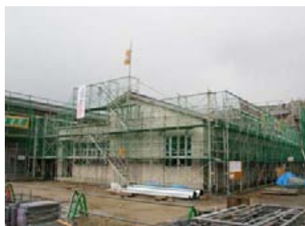
現在建築中の奈古小学校
