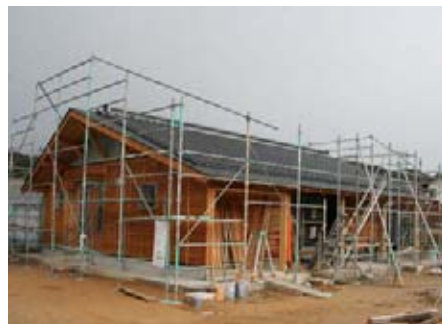
岡田橋団地集会所施設新築工事
