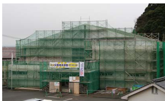
宇田ふれあい体育館屋根等補修工事
