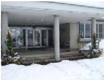
雪に埋もれたのうそんセンターの門松
