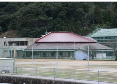
ひだまりの里屋根防水工事
