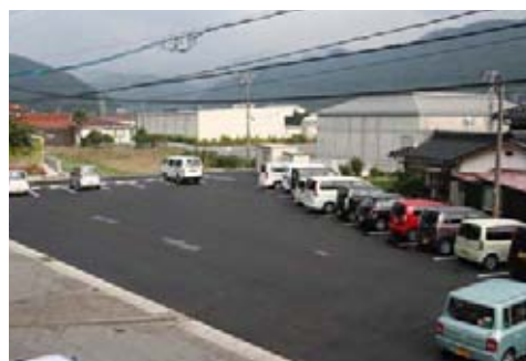
舗装整備された町立みどり保育園駐車場
