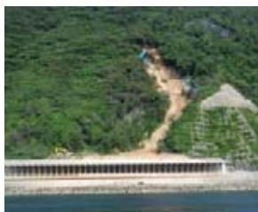
国道191号事前通行規制区間(洞門付近)
