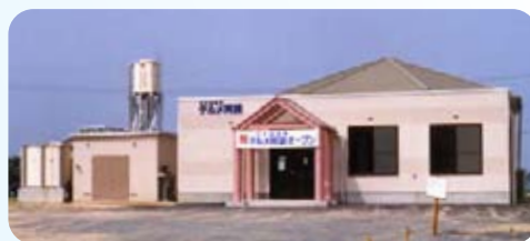
平成4年の竣工から20年が経過 完成当時のテルメ阿胡
