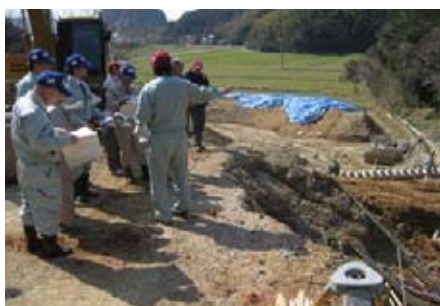
堤ヶ浴ため池
