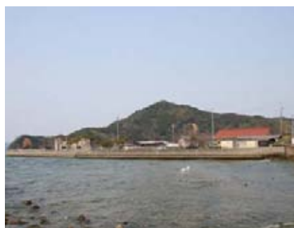
奈古漁港(矢板護岸)
