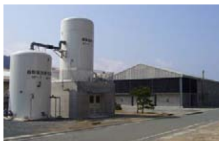
外海第二栽培漁業センター (キジハタ種苗生産棟)
