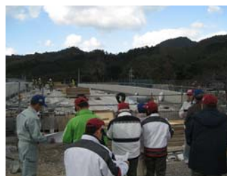
町道汐入野地線道路新設工事
