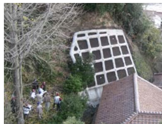
小規模治山久保地区山腹工事
