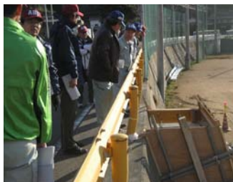
宇田郷ふれあいグラウンド階段設置工事
