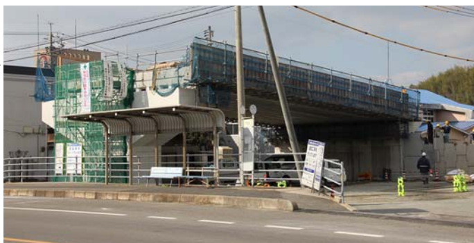
工事が進む 町道汐入野地線の高架橋
