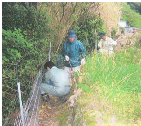
防護柵設置の様子
