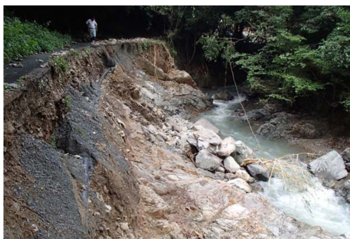
↑県道福田下惣郷線の大規模な路面の崩落(惣郷)
