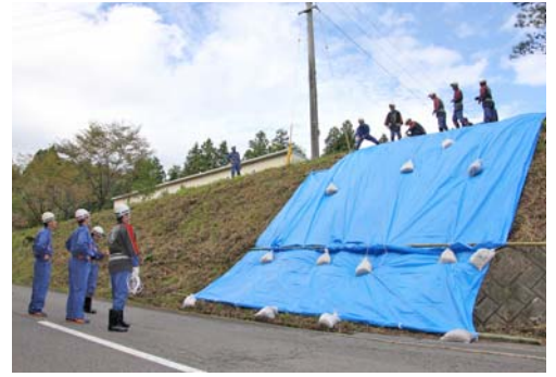
シート張り工法訓練
