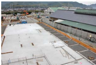
建設工事が進む道の駅阿武町
