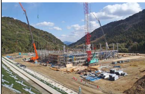
建設工事の様子（3月上旬 萩市山田）
