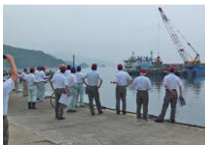
宇田郷漁港浚渫工事
