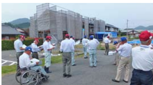
岡田橋公営住宅建設工事
