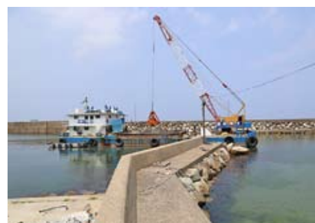
尾無地区泊地浚渫工事
