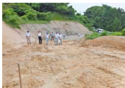
町道長浜西ヶ畑線道路改良工事
