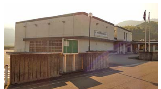
太陽光発電設備を設置する ふれあいセンター
