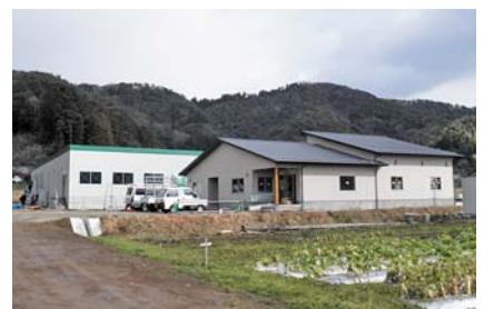
工事中の「のんきな農場阿武事業所」
