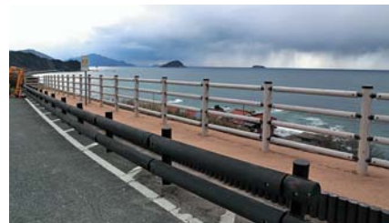
木製転落防止柵(長浜パーキング)
