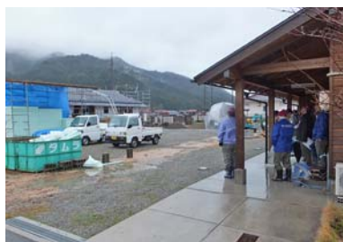
岡田橋団地（単身者用）住宅新築工事
