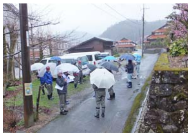
町道亀山十王堂線道路改良工事
