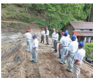
ため池改修工事 (亀尻第2工区)
