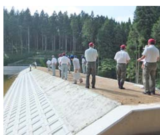
ため池改修工事 (石原工区)
