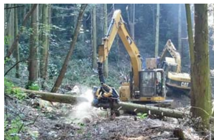
大型機械を使った林道整備
