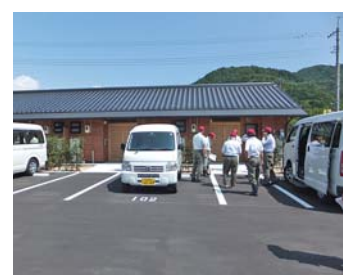
岡田橋単身者用 住宅新築工事
