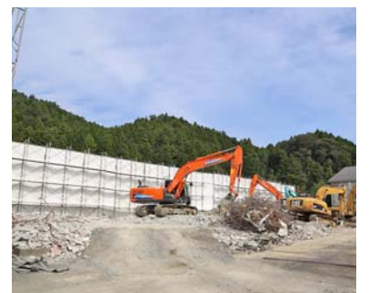
校舎解体工事中の福賀中学校跡地
