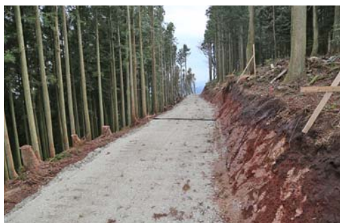
林業専用道(東イラオ山線)
