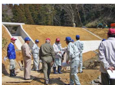
ため池改修工事 亀尻第2工区
