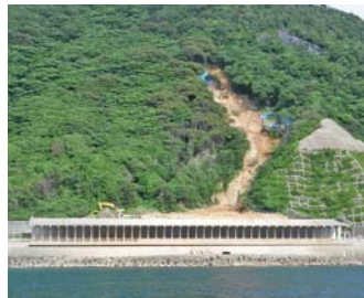
国道191号木与洞門付近
