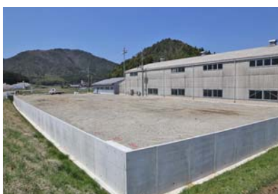
福祉複合施設建設予定地
