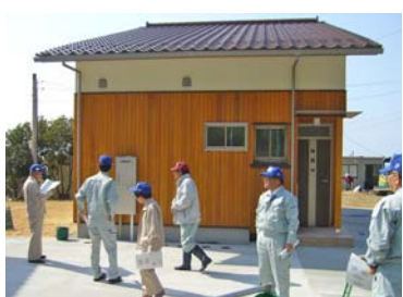
公営住宅尾無団地
