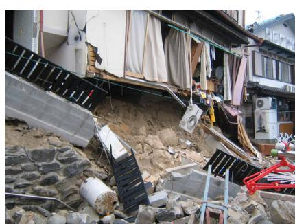
石積み擁壁の崩壊による家屋の被害(福岡県西方沖地震)
