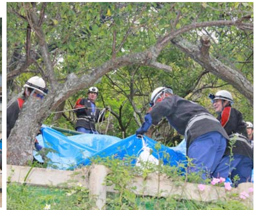
シート張り工法
