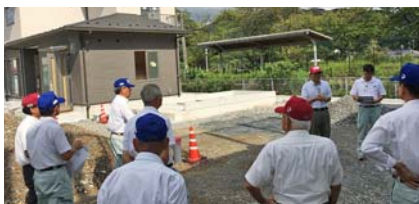
萩警察署奈古駐在所新築工事
