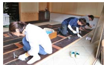
1階の床材を釘打ち
