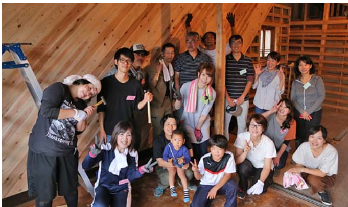
旧奈古薬局2階の壁張りも進みました！
