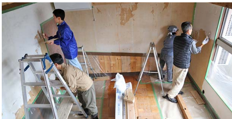
手分けして壁塗り作業（2階漆喰塗りチーム）！
