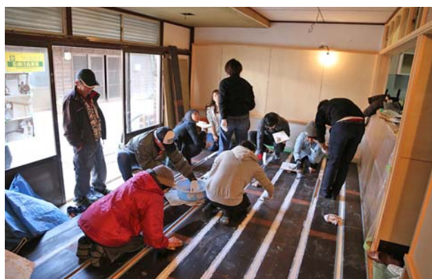
1階エントランスの床仕上げ作業
