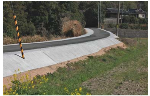
路肩整備（宇久地内）
