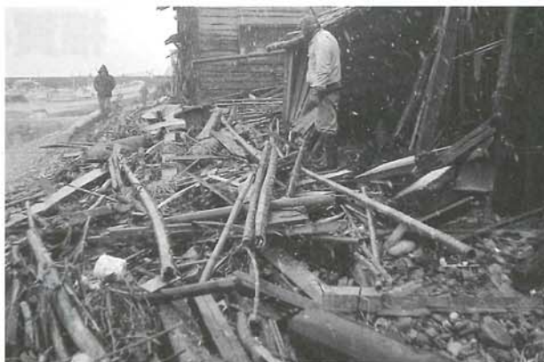
高潮により崩壊した建物
