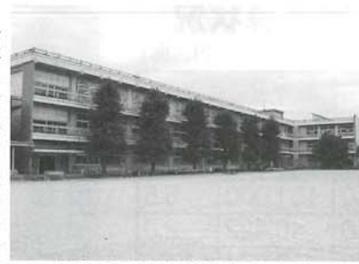
耐力度調査が予定される 奈古小学校舎
