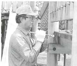
遊具のボルト点検
