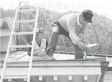
林業センター屋根修理
