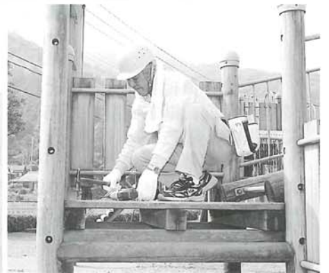
遊具の安全点検
