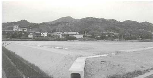
岡田橋団地新築工事予定地
