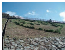
よく手入れされた法面
