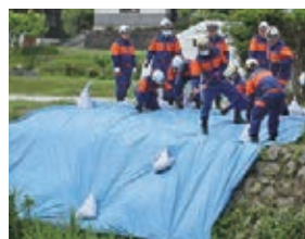
崖崩れを防ぐ「シート張り」
