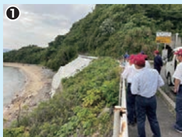
田部青浦線 法面崩壊防止工事
