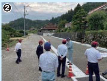
亀山十王堂線 道路改良工事
