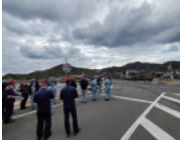
鹿島大橋橋梁補修工事
