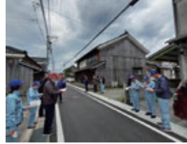
町道舗装改修工事 (奈古地区)
